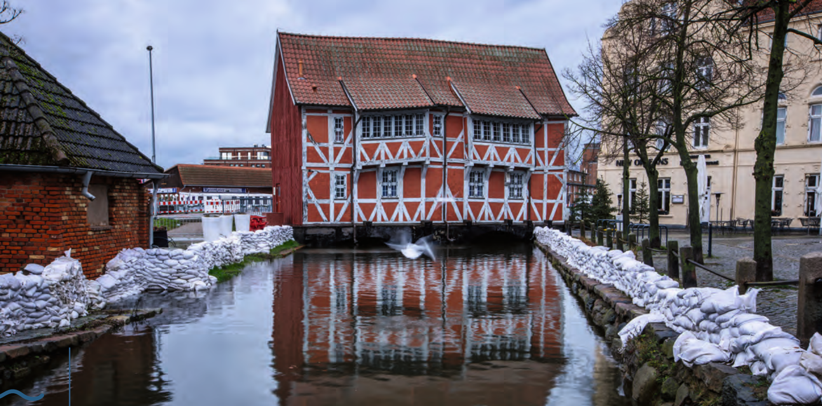
Historisches Speichergebäude in der Weltkulturerbe-Stadt Wismar: Sandsäcke gegen die Fluten
